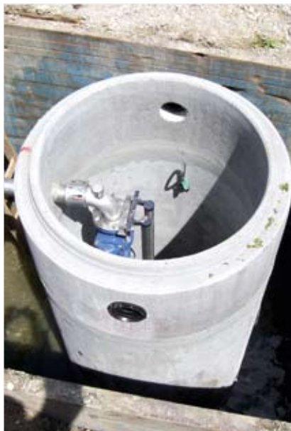
► monolithischer Pumpenschacht aus Stahlbeton B55
