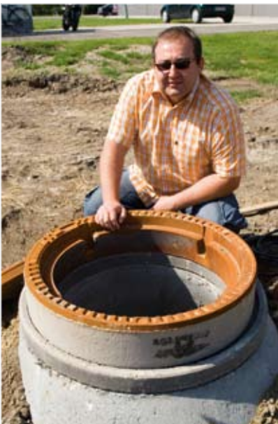
► Grundfos Vertriebsrepräsentant Maik Wötzel kontrolliert die eingebauten Schächte.
